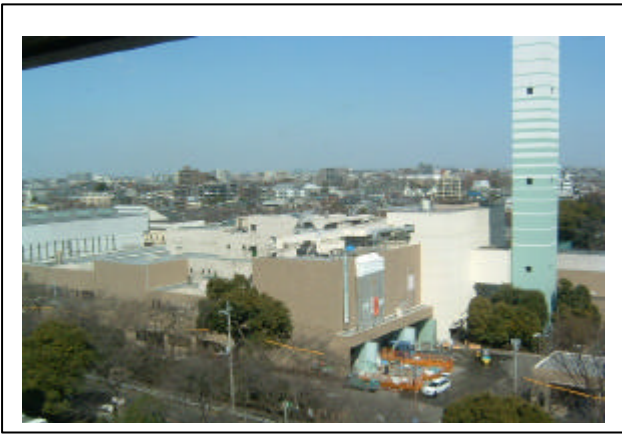
クリーンセンターの全景（隣接する市庁舎から）
