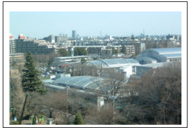
付帯施設（温水プールなど）
