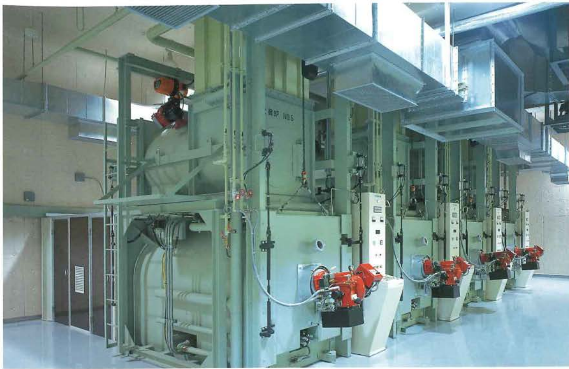
炉室1階（作業室）
